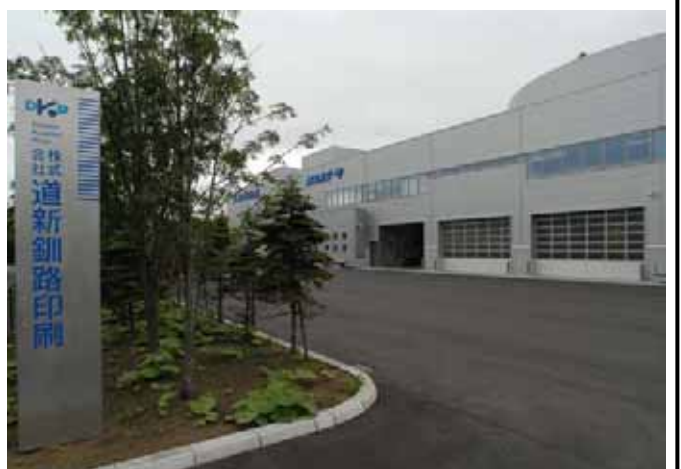
製造工程見学コースを備えた道新釧路印刷工場
