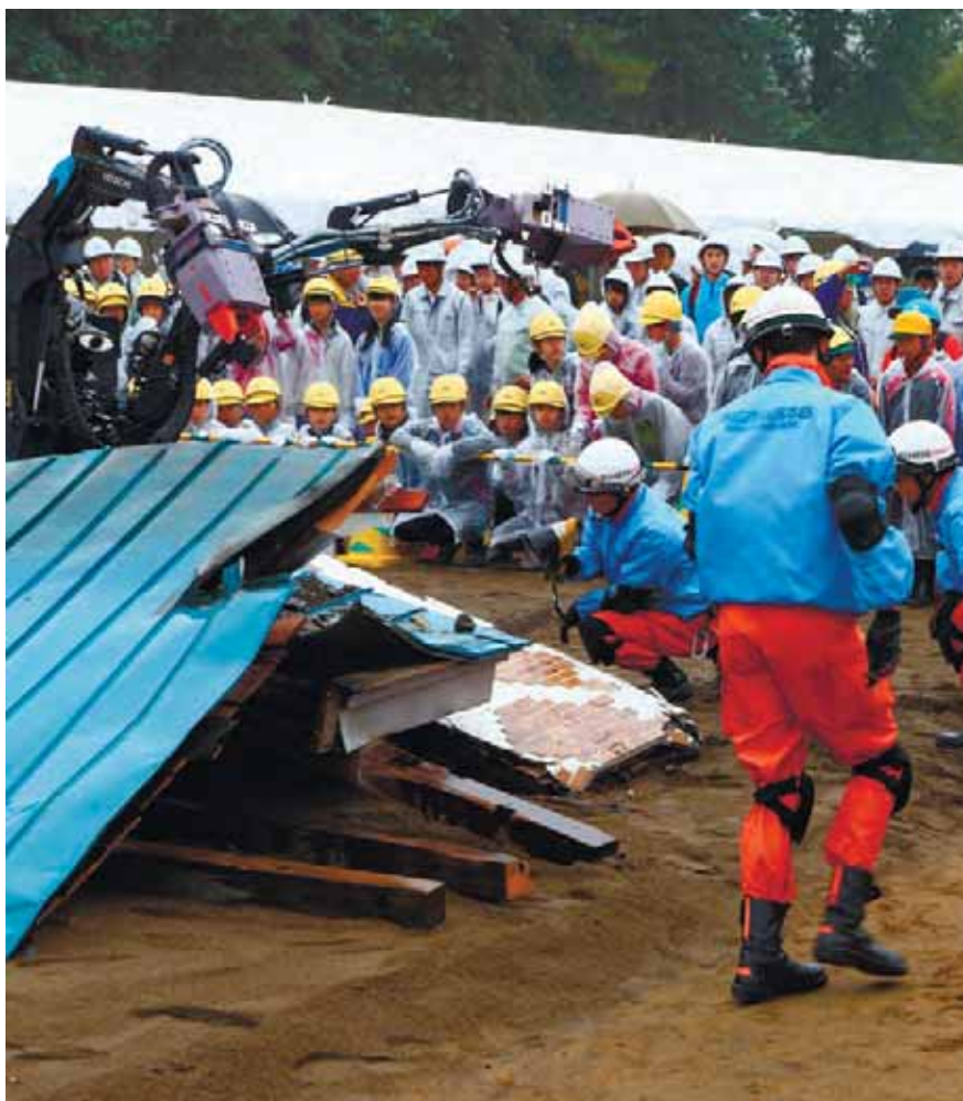
がれき撤去を見守る小学生
